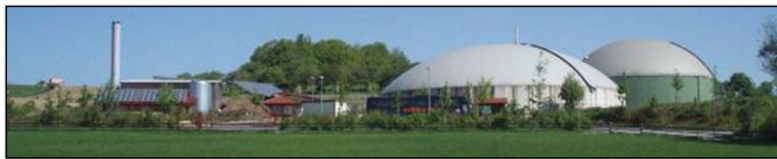
photo 1: unité de biométhanisation (Source : photo Energie & Développement local)
