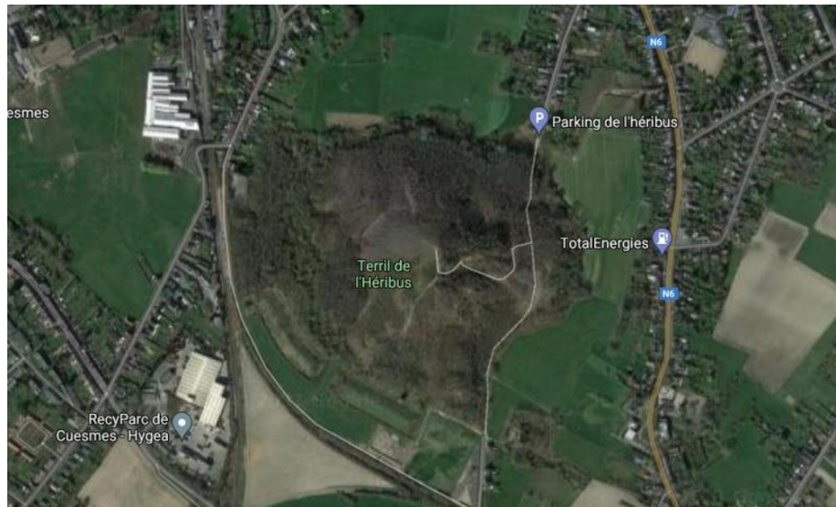
Figure 1 : vue aérienne du terril de l'Héribus
